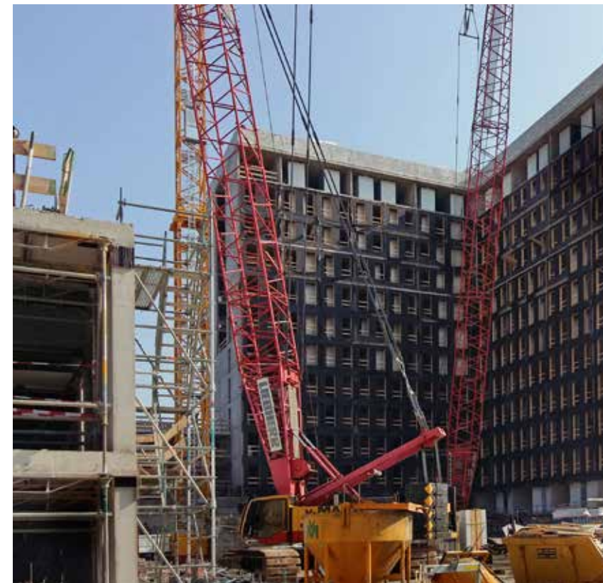
De montagelogistiek van de verschillende uitvoerende partijen hangt nauw samen.
